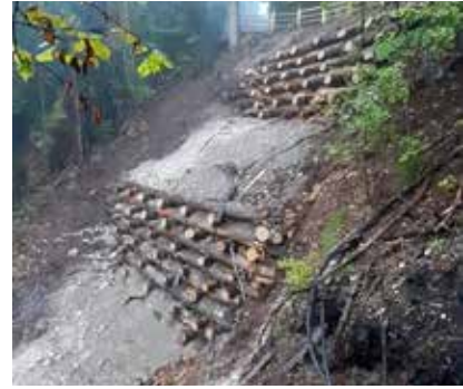
Aufgrund von Rutschungen war die Verbauung nötig.
