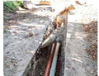
Im Gemeindegebiet laufen verschiedene Grabungsarbeiten.
