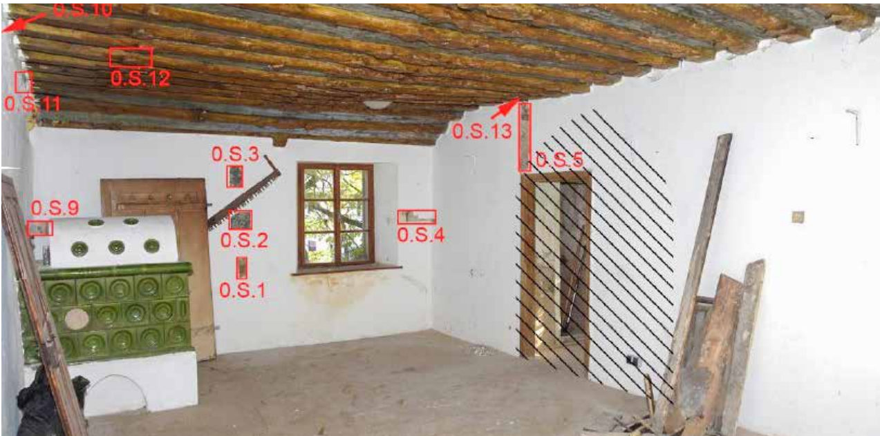
Stube im Osttrakt, gewölbte Balkendecke und vermauerter Zugang zum Erkerraum
