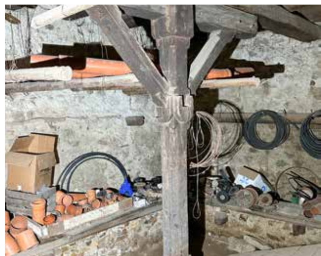
Osttrakt, Keller, Gabelstütze, Datierung um 1300
