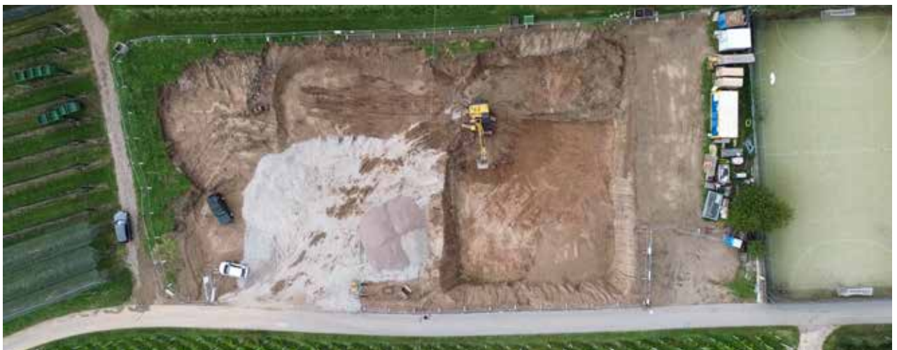
Ein Blick von oben auf die durchgeführten Aushubarbeiten.
