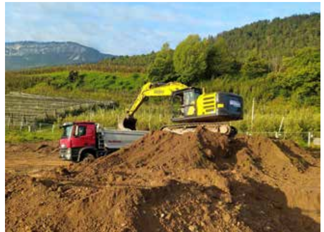
Einblicke in die wochenlangen Aushub- und Vorbereitungsarbeiten.
